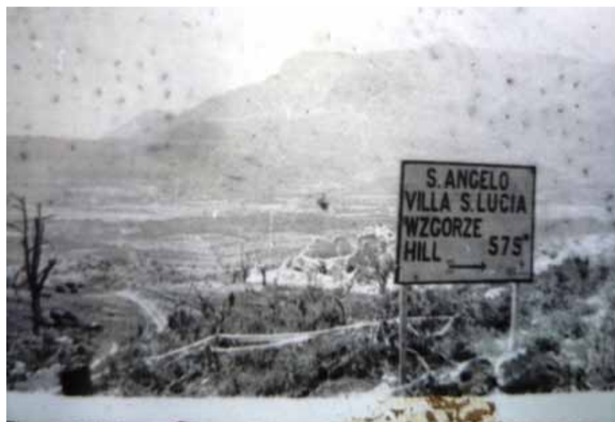
Płaskowyz i ruiny Masseria Albaneta widziane z południowego Widma w okolicach Gardzieli. Fot. ze zbiorów K. Piotrowskiego.
