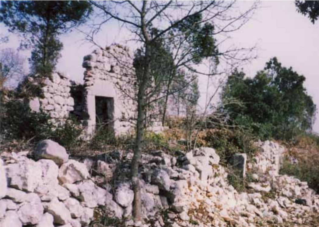
Okolice przy zachodniej ścianie Domku na Widmie. Fot. K.Piotrowski, 01.02.02 r.
