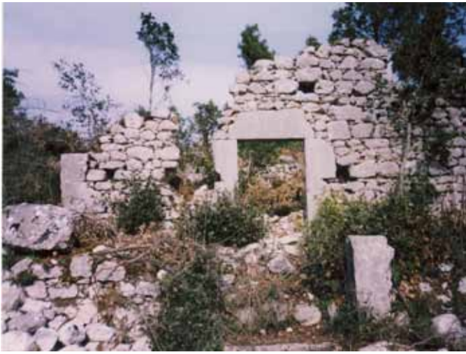
Frontalna ściana Domku na Widmie od zachodniej strony. Fot. K.Piotrowski, 01.02.02 r.
